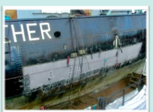
Die neue Stahlplatte ist eingepasst und fixiert.
