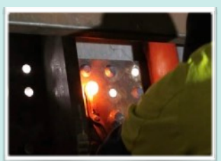
Der glühende Niet sitzt fixiert in der Bohrung.
