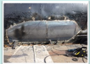
Die Notreparatur von Rostock. Das geschweißte „Pflaster“.
