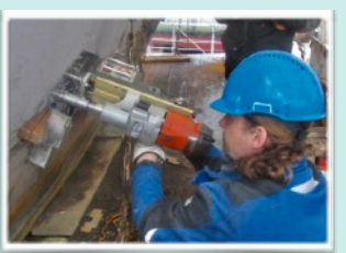
Löcher bohren für die neuen Niete.
